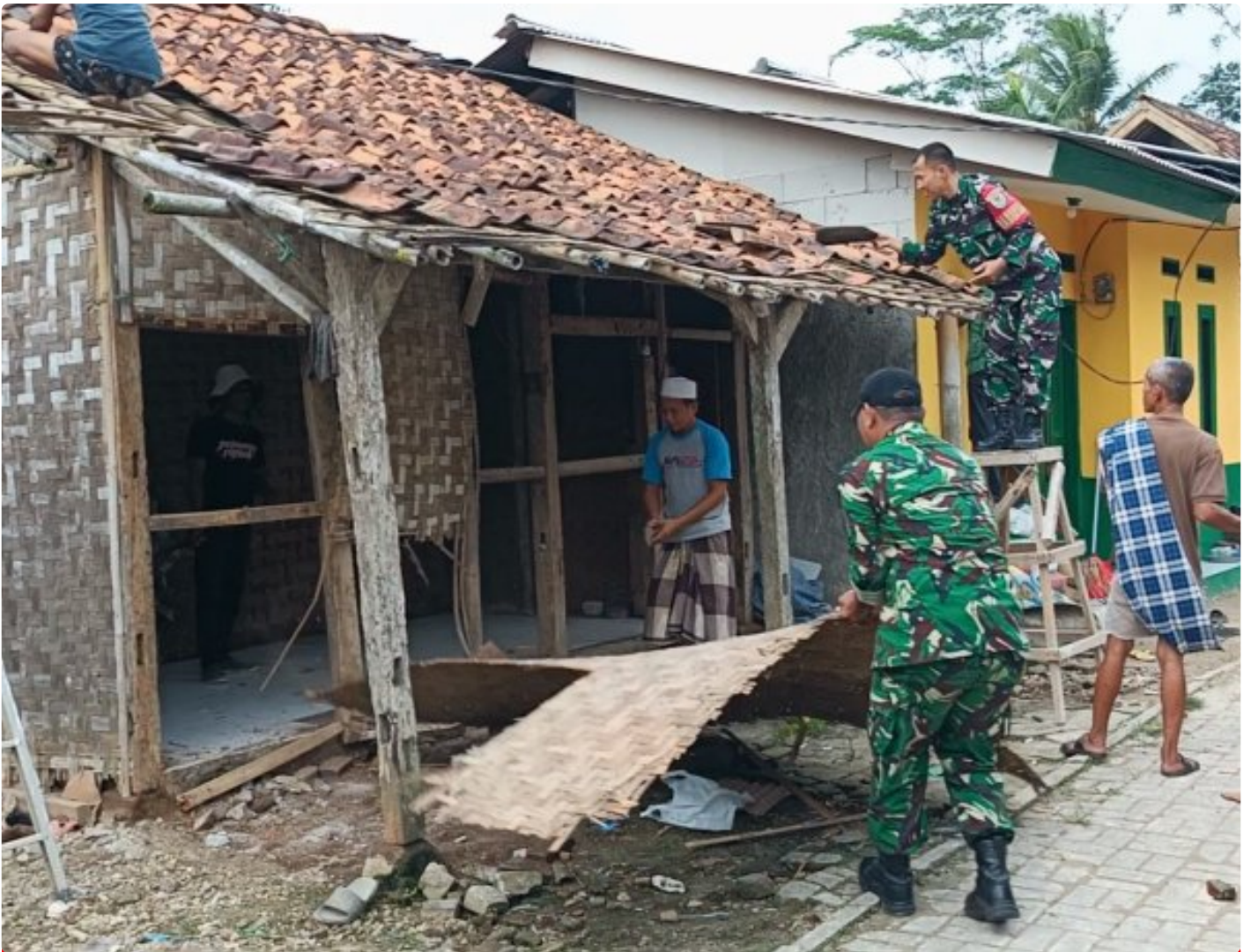
Pembongkaran Rumah Bapak Narmin
